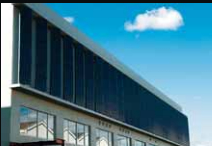
Unsere Produktionsstätten sind mit unseren eigenen Photovoltaikanlagen ausgerüstet.
